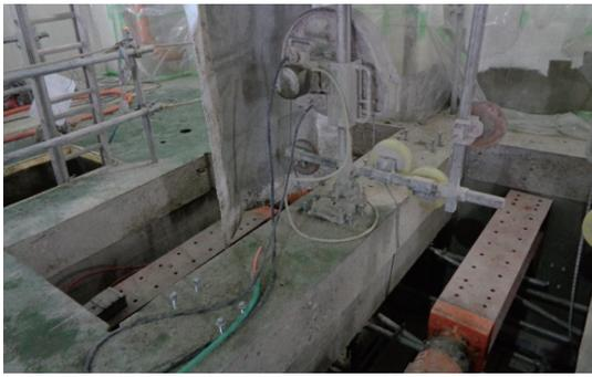
写真-1 ワイヤソーによるコンクリート切断
