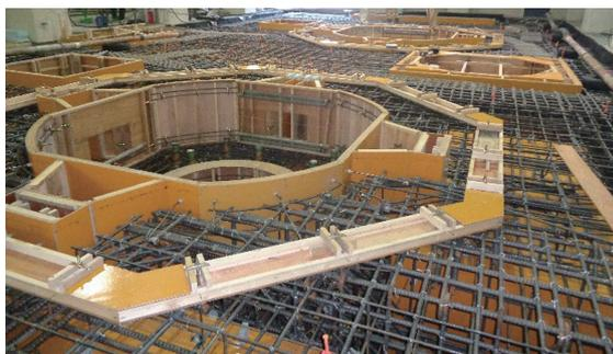
写真-3 鉄筋加工組立状況
