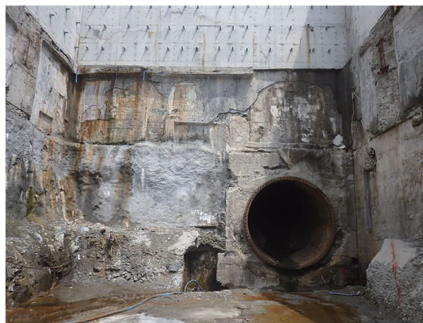
写真-1 現場状況(施工前)
