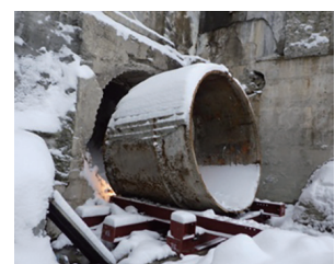
写真-3 鋼管引出し完了
