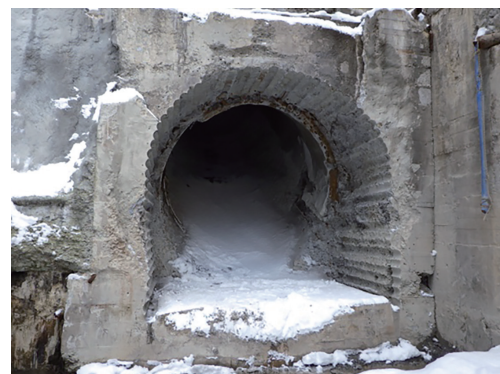
写真-4 現場状況(施工完了)
