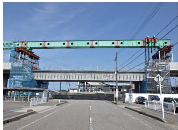
写真-2 主桁送り出し架設全景
