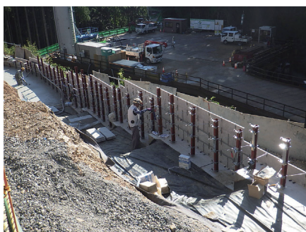
写真-1 壁面材の設置
