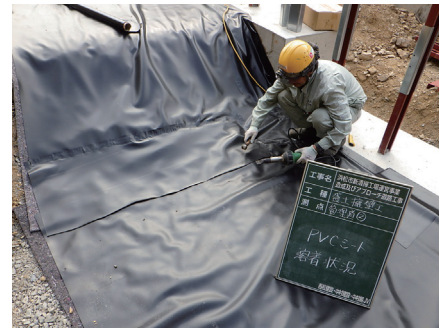
写真-2 防水シート圧着状況
