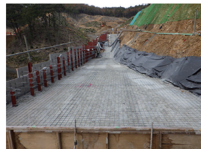
写真-3 溶接金網設置状況
