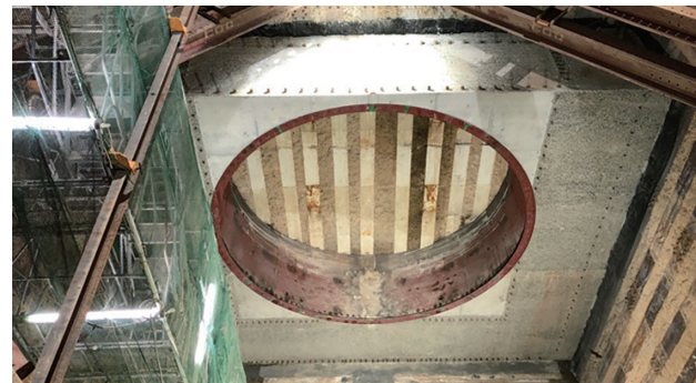
写真-1 坑口コンクリート全景写真
