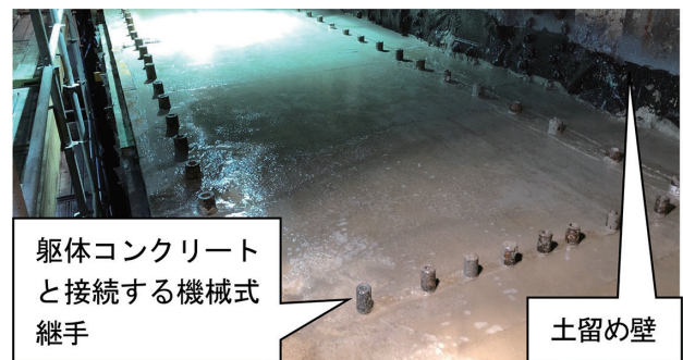
写真-2 機械式継手拡大写真 (天端部)
