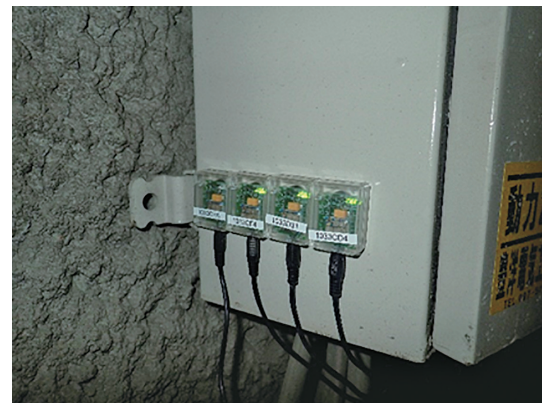
図-3 電力センサー設置状況
