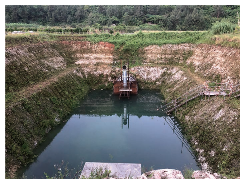
写真一5 地下水位上昇（2020年）
