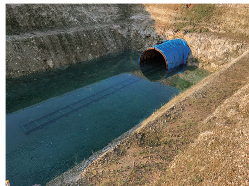
写真一3 地下水位上昇（2019年）
