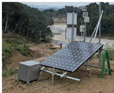
写真-1 ソーラー電源システム
