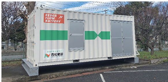
写真-1 実証試験装置の外観
