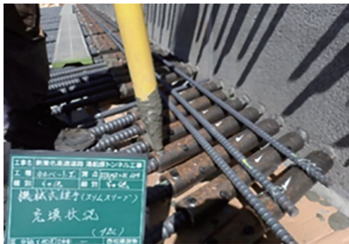
写真-2 機械式継手施工状況
