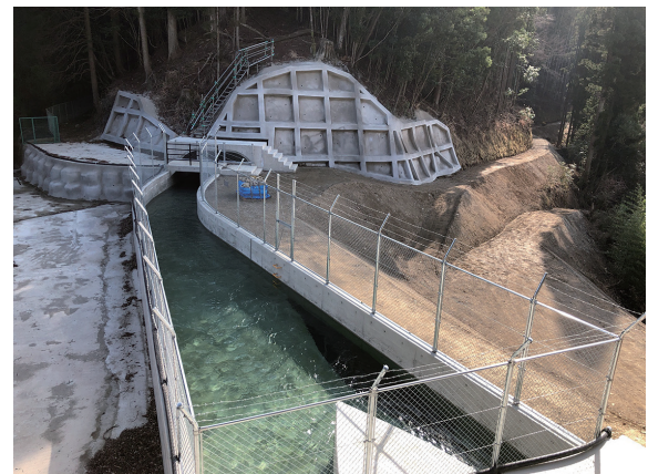
写真二 工事完成
