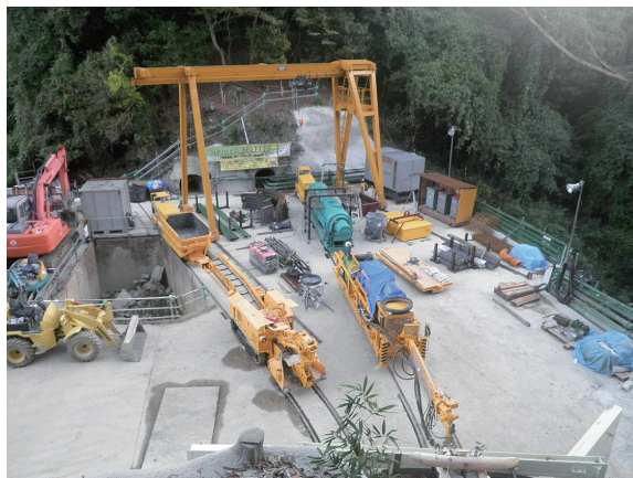
写真一 坑口ヤード仮設置
