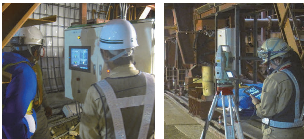
制御盤によるセット操作
