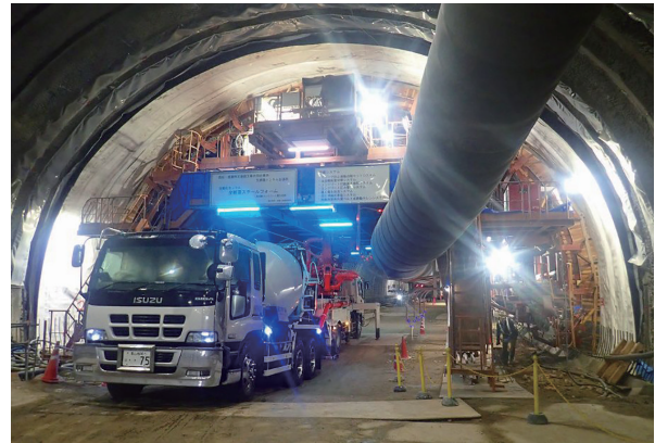
写真-2 覆工コンクリート自動打設状況
