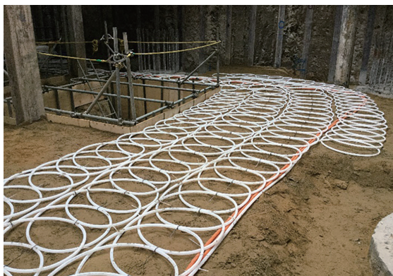
写真-1 地中熱交換器の敷設状況
