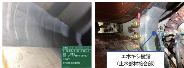
写真-4 エポキシ樹脂による平滑化 (左：シールド機、右：止水部材)
