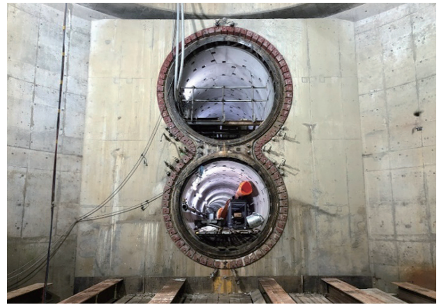
写真一10 坑口全景
