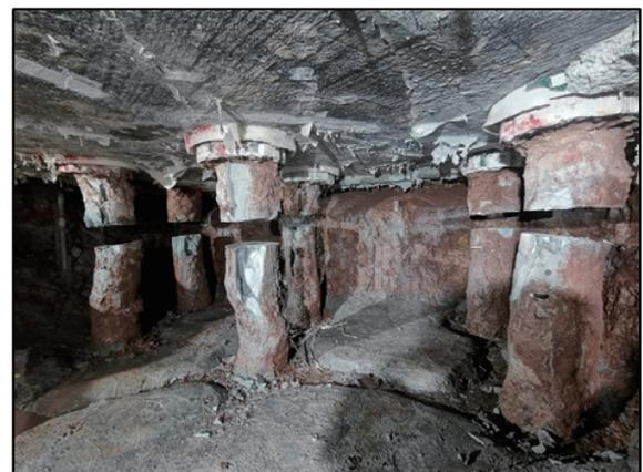
写真-5 既設基礎杭の切断 (P51)
