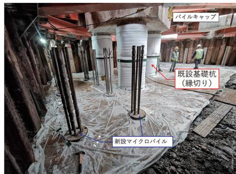
写真-2 発泡スチロールによる既設基礎杭縁切り
