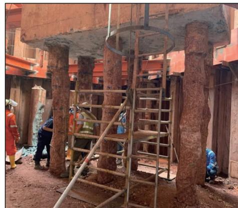
写真-3 既設基礎杭の施工不良
