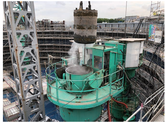
写真—8 マテリアルロックからの排土状況
