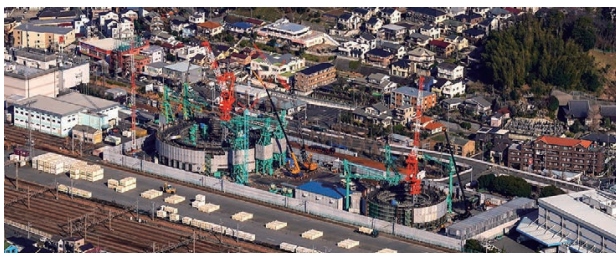
写真一1 非常口（左）と資材搬入口（右）
