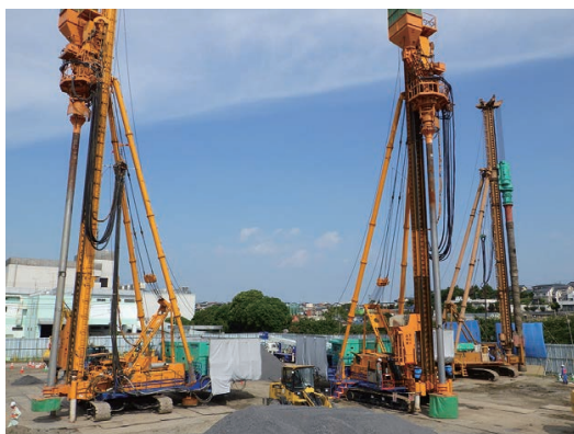
写真-2 地盤改良の施工状況（非常口）
