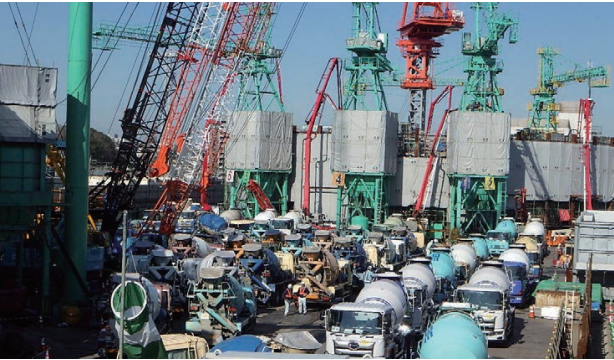
写真-5 コンクリート打設の状況
