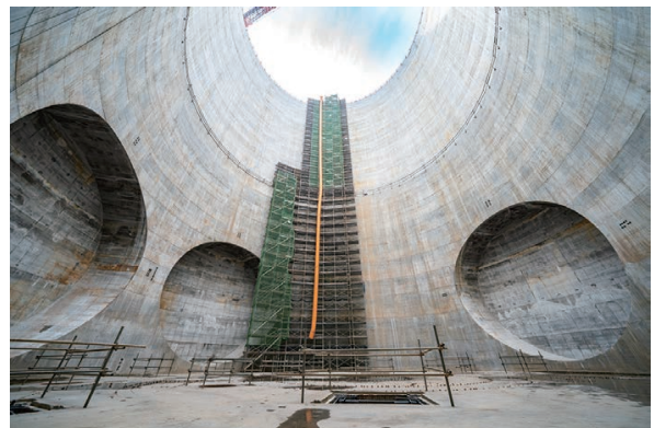
写真-10 非常口の完成
