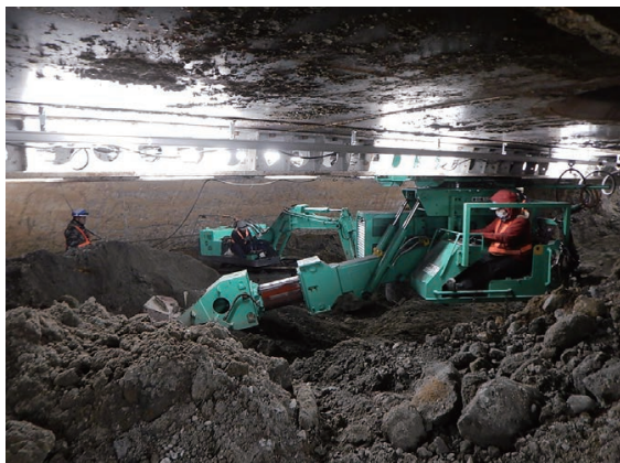
写真—6 函内の掘削状況
