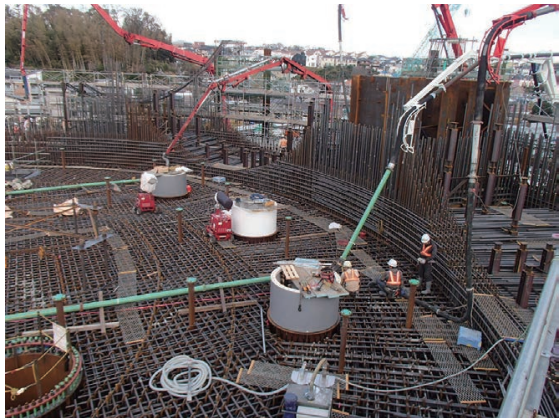
写真－3 底盤、シールド開口、離隔壁の状況（非常口）
