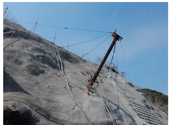
写真-5 SD工法施工状況
