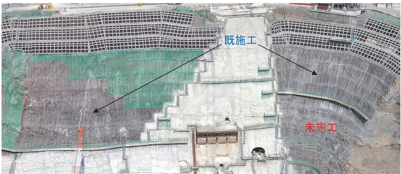
写真-6 DC ネットを敷設した未施工部と施工完了した箇所の比較写真
