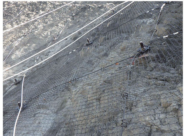
写真一7 DC ネット工法近景
