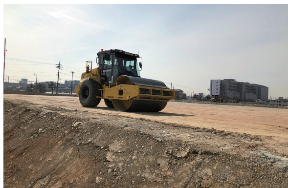
写真一 転圧管理システム搭載の振動ローラー
