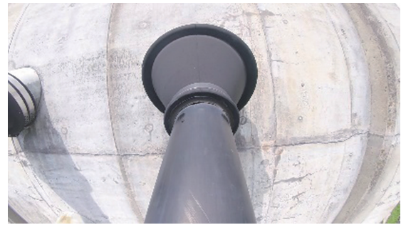
写真-7 主塔定着部撮影例
