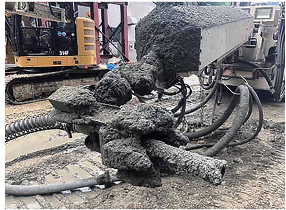
写真-5 レーダ部分へのリバウンドの堆積状況
