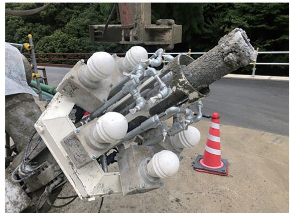
写真-6 エアー及び水洗浄装置のリバウンドの堆積状況
