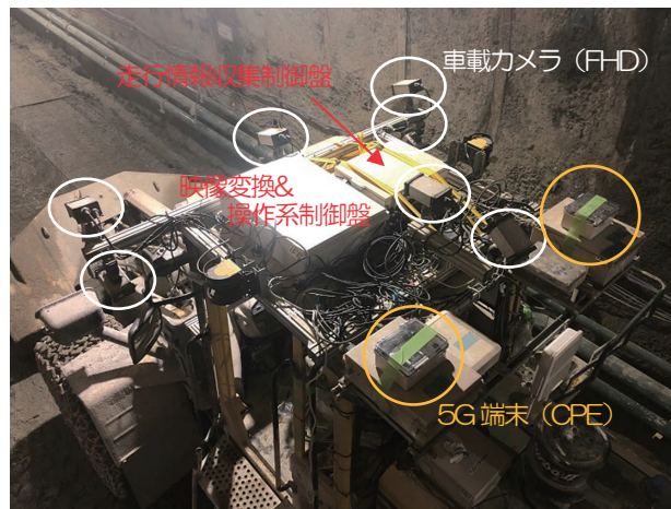
写真-9 ホイールローダ搭載ユニット設置状況 (L5G)
