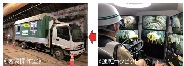
写真二 遠隔操作室・運転コクピット
