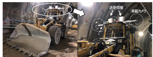
写真三 ホイールローダ搭載ユニット設置状況
