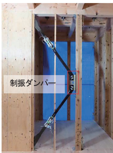
写真-2 制振ダンパー外観
