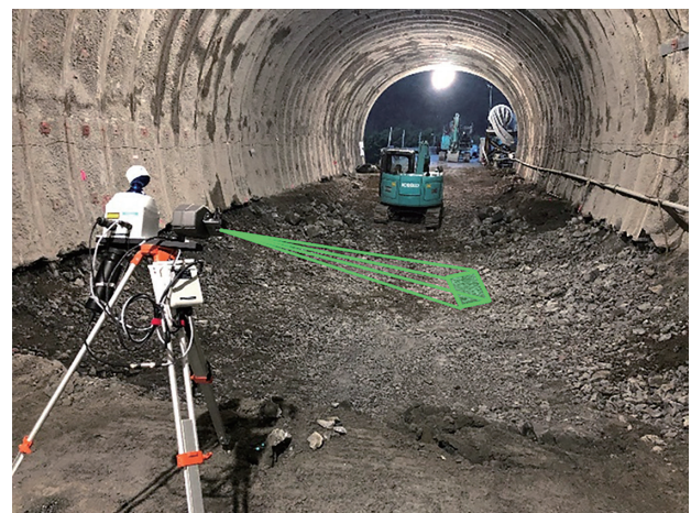
図-4 現場計測状況（レーザ光はイメージ）
