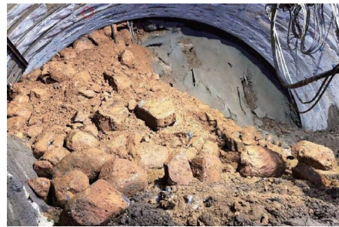
写真-2 天端崩落状況 (No.142+15.7)
