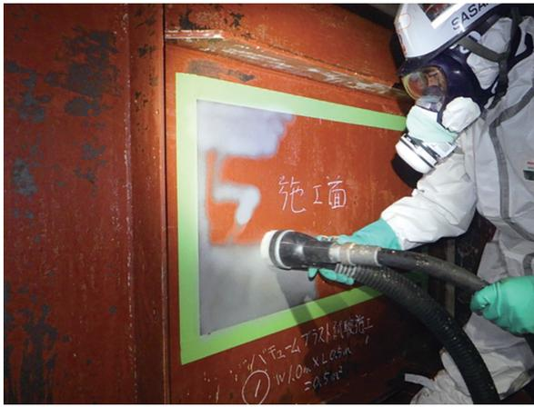
写真一2 バキュームブラスト施工状況
