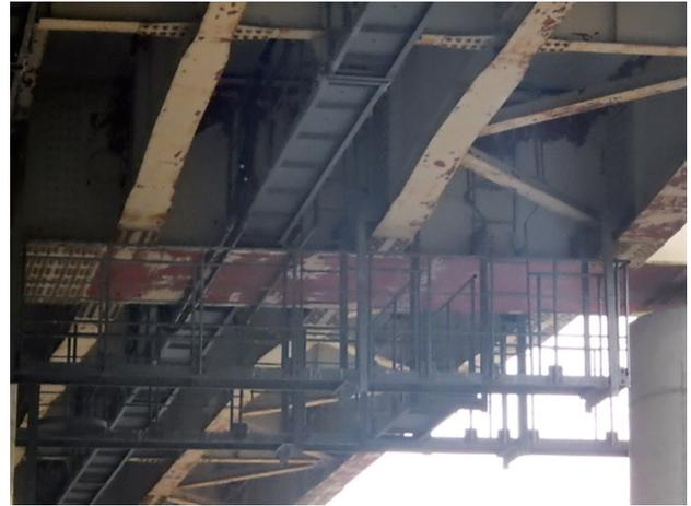
写真-1 鋼桁 塗膜劣化
