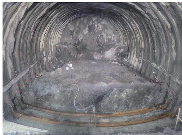
写真-1 インバートストラット施工状況
