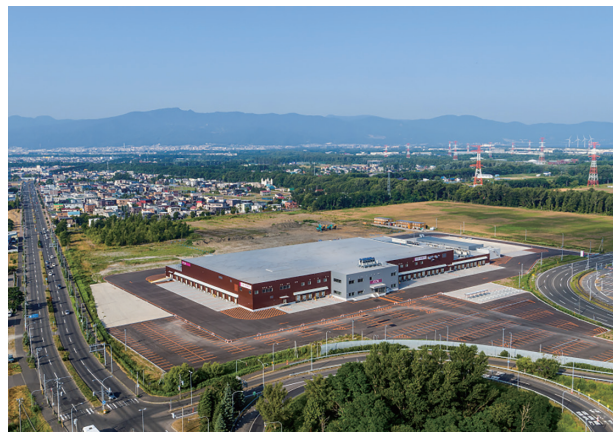
図一 施設全景
