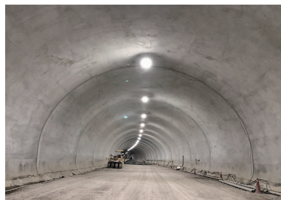
写真一4 覆工コンクリートの仕上り
