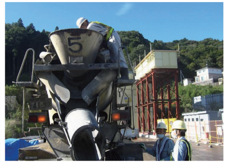
写真一-1 VSP 後添加による流動化コンクリートの製造
