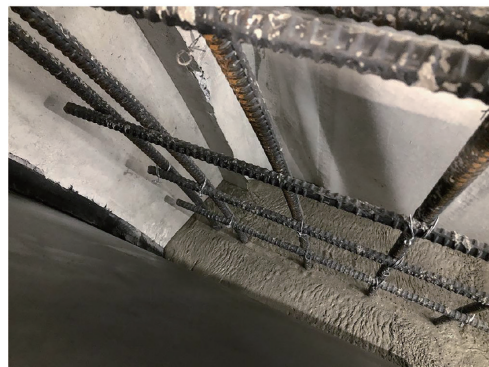
写真一3 覆工コンクリートの流動状況
