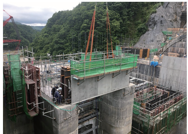
写真一3 上流断面変化部施工
