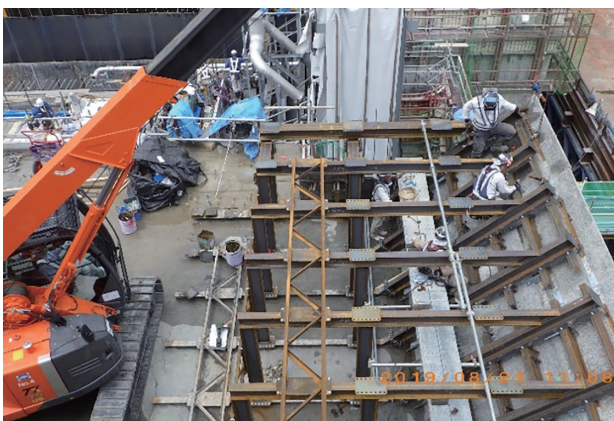
写真一1 上流張出部施工
