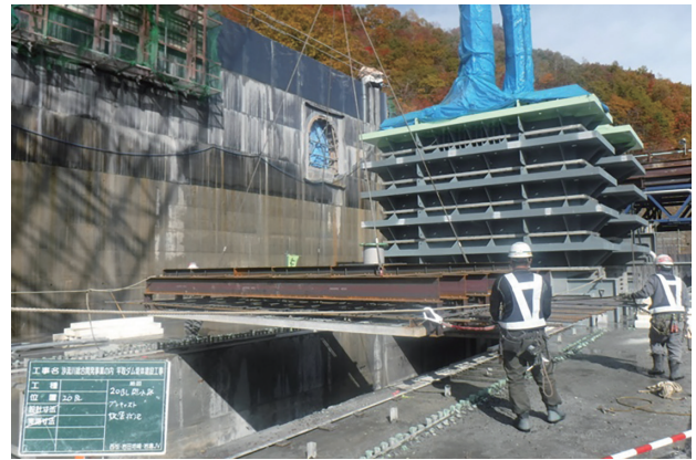
写真一2 水路天端部施工
