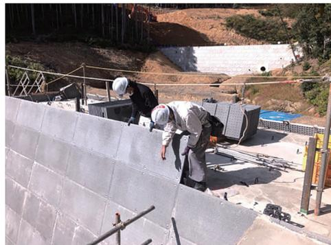
写真-1 残存型枠の設置
