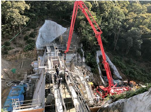
写真一2 コンクリート打設状況
