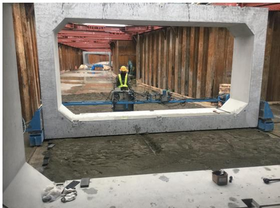
図-3 函体運搬状況写真
