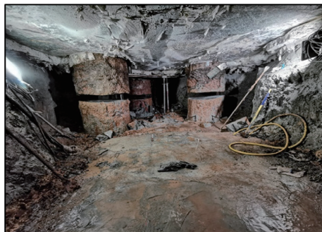
写真二 既設基礎杭切断
