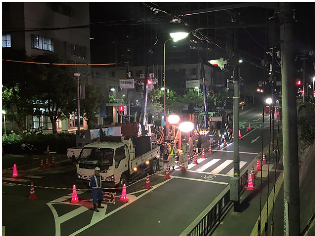
図一1 引抜状況写真
