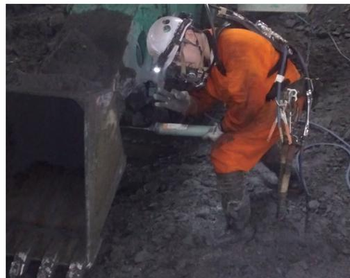
写真四 ヘリウム混合ガス利用作業の状況
