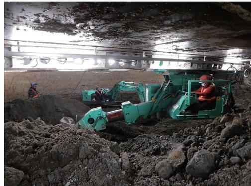
写真三 函内の掘削状況
