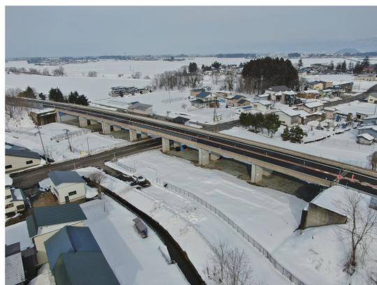
写真二 下根田橋（RC 巻立て補強工 4 基）
