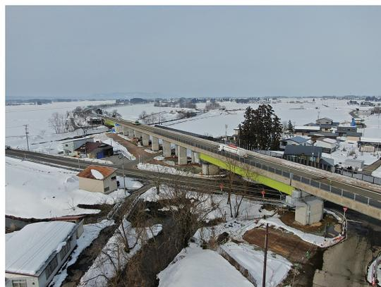
写真一 大戸川橋（RC 巻立て補強工 13 基）
