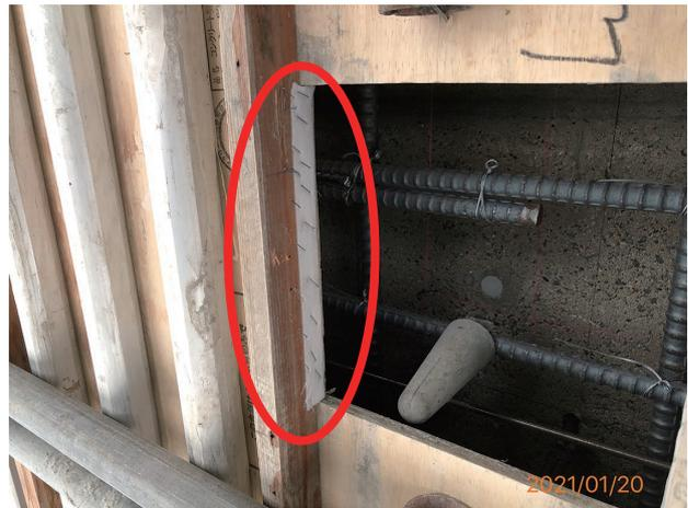
写真-8 隙間テープ設置
