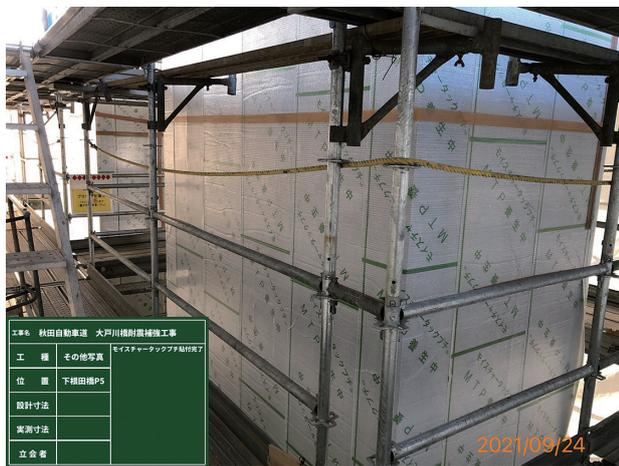
写真-6 気泡緩衝シートによる養生
