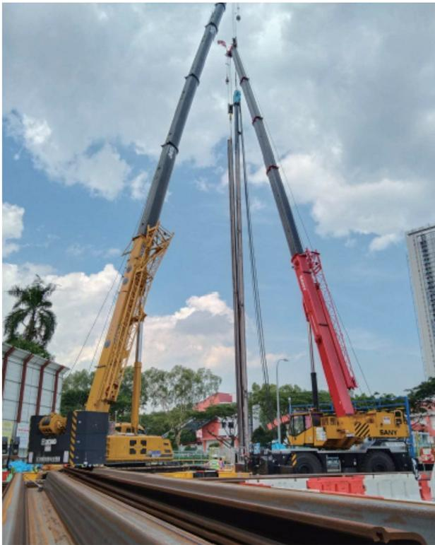
写真-1 ハット型鋼矢板圧入状況
