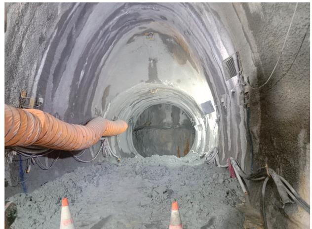
写真—6 立坑下端横坑掘削状況
