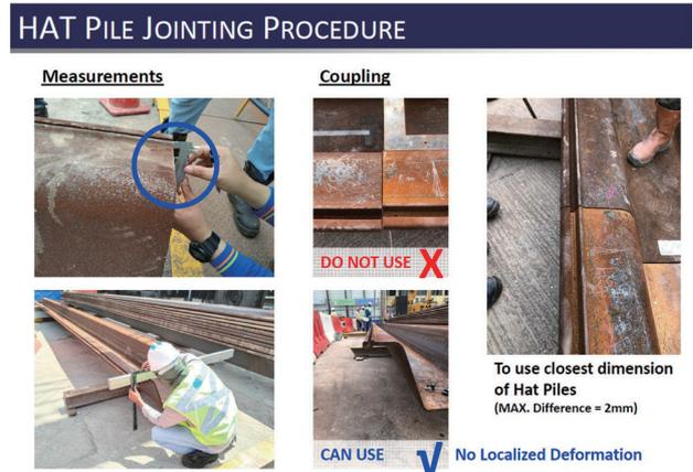
写真-3 鋼矢板寸法計測状況
