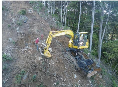
写真-3 高所法面掘削機による整形
