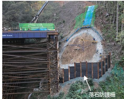
写真-4 自立式親杭横矢板による落石防止対策
