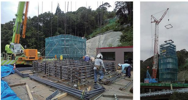
写真一9 作業構台での鉄筋組立と組立鉄筋の揚重
