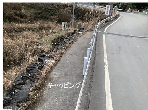
写真-1 大型土のう背面へのキャッピング
