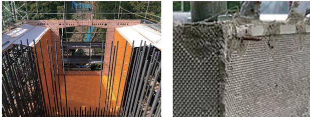
写真一11 KK シート設置状況と脱型後の凹凸
