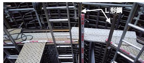
写真-8 大口径深礎杭内の鉄筋組立架台・足場
