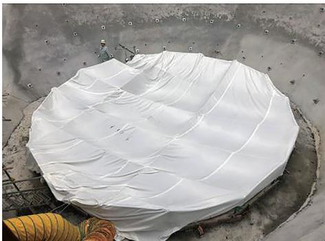
写真-6 大口径深礎杭での防音対策
