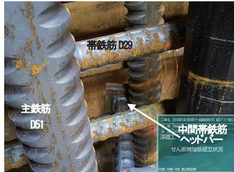
写真-7 大口径深礎杭の中間帯鉄筋
