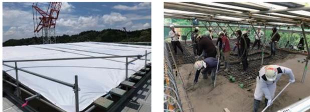
写真一12 柱頭部コンクリート打設状況
