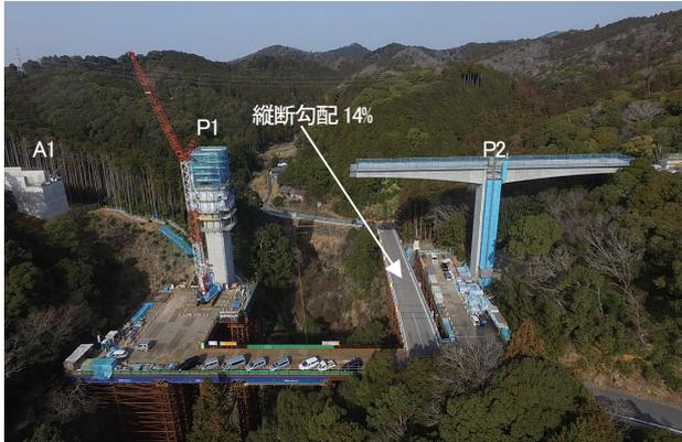
写真-2 仮設構台全景
