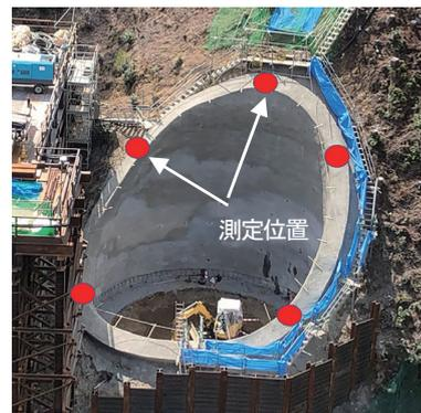
写真-5 竹割型土留めの動態観測点
