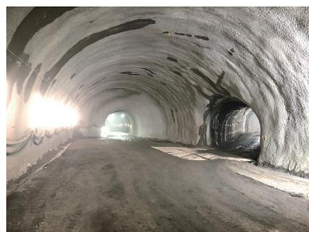
写真-2 避難坑交差部吹付覆工完了
