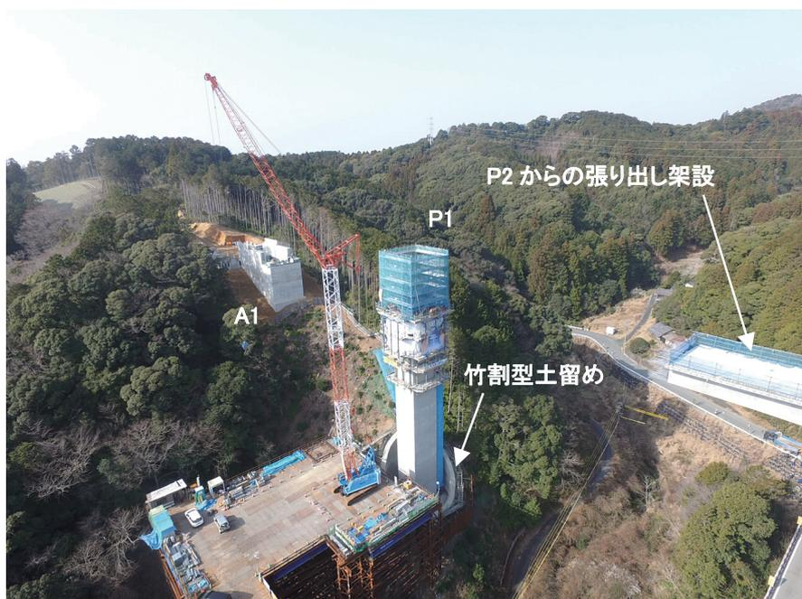
写真-1 PC 3 径間連続ラーメン橋の施工
