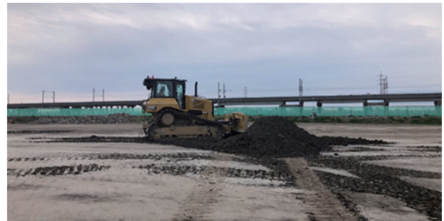
写真-3 3DMC 対応ブルドーザによる施工状況
