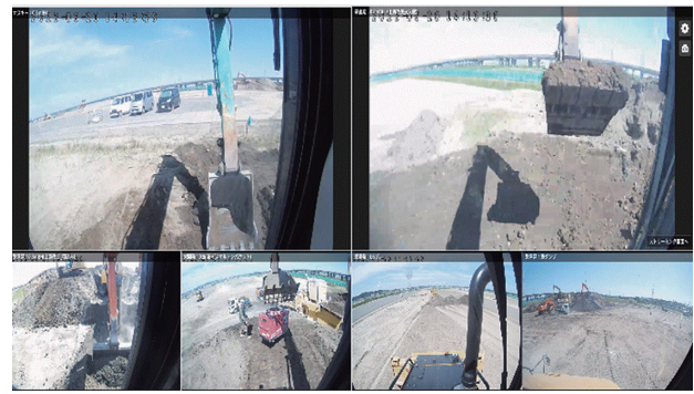
写真-7 現場事務所での Web カメラ画像のモニター状況
