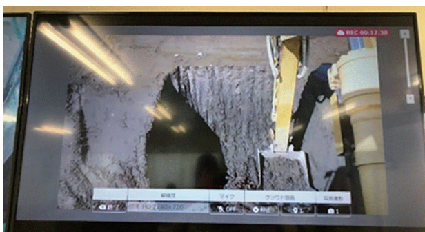
(b) 現場事務所
