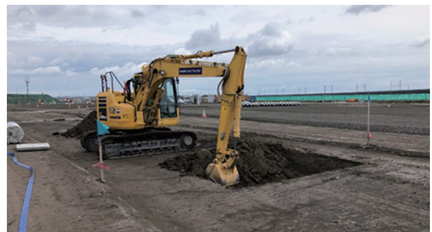
写真-4 3DMC 対応油圧ショベルによる施工状況
