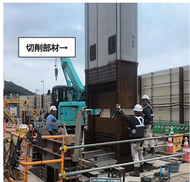
写真ー1 NS-BOX 建て込み状況
