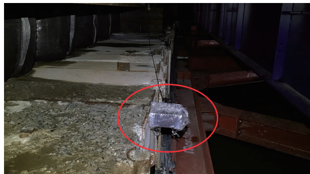
写真一2 振動計設置状況
