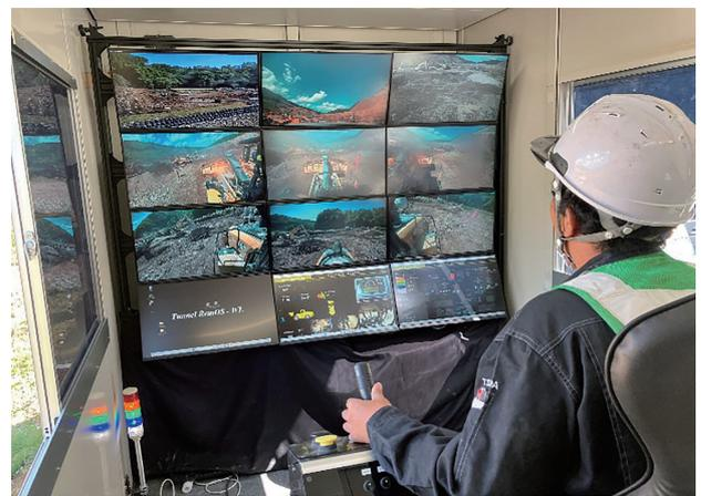
図-7 Tunnel RemOS 操作室
