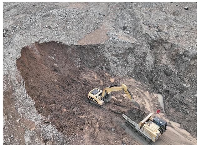
図-14 遠隔操作機による施工状況
