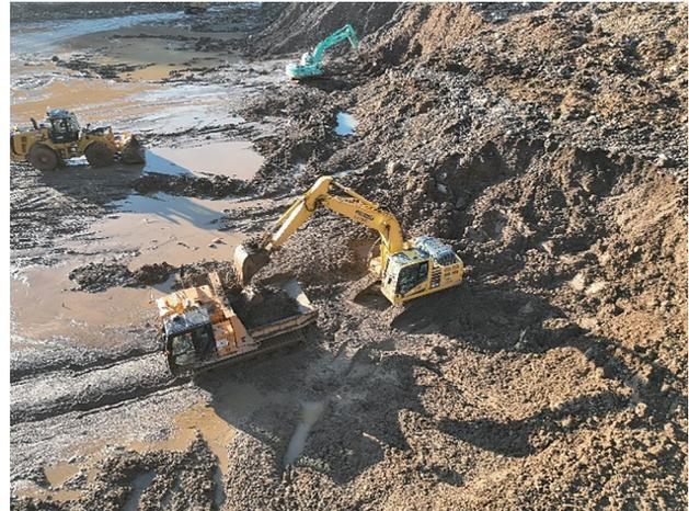
図-12 遠隔操作機による施工状況
