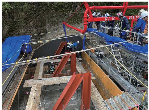
写真一12 ディストリビューターでの打込み作業
