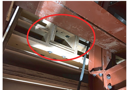
写真-7 側壁部 検査窓
