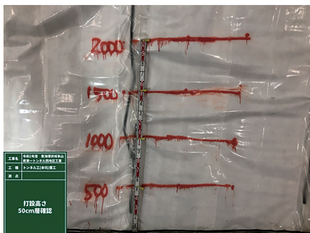
写真-2 防水シートマーキング状況
