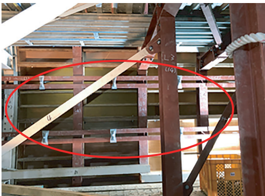
写真-5 セパレータ設置状況（セントル外面）
