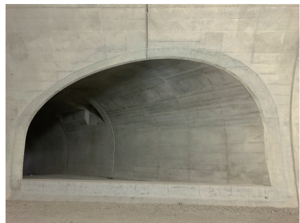
写真一8 打設完了状況
