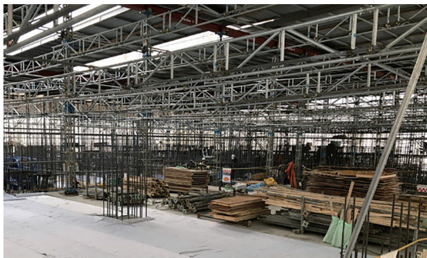
写真-5 養生上屋内の状況
