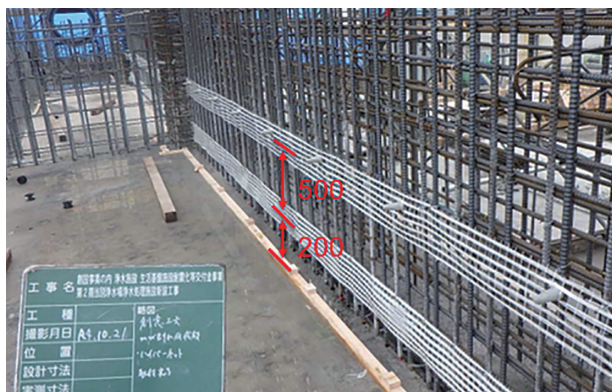
写真-8 ハイパーネット設置状況
