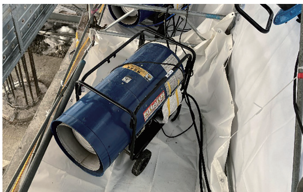
写真-6 温風ヒーター設置状況
