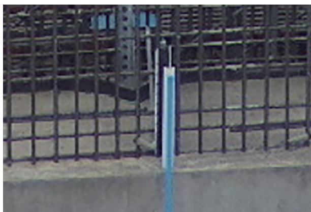
写真-9 ひび割れ誘発目地設置状況
