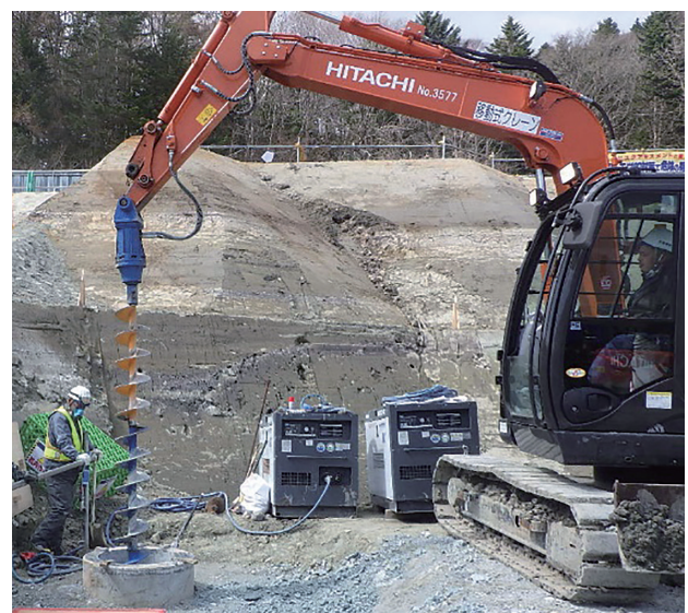
写真－2 杭内部掘削状況
