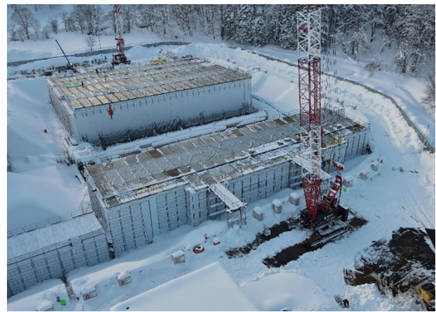
写真－3 冬季施工全景
