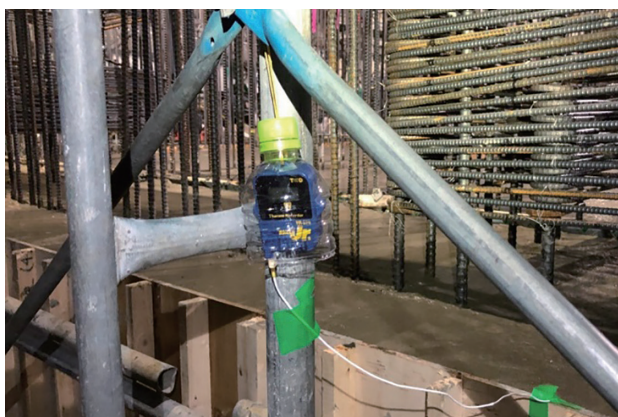
写真-7 コンクリート温度計設置状況
