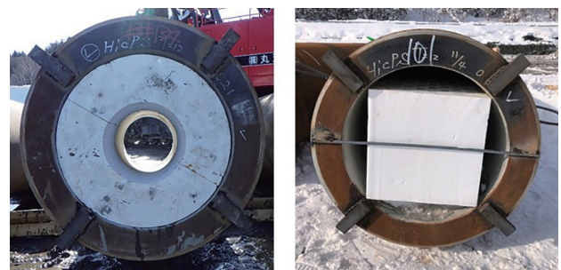
写真－1 EPS 設置状況
