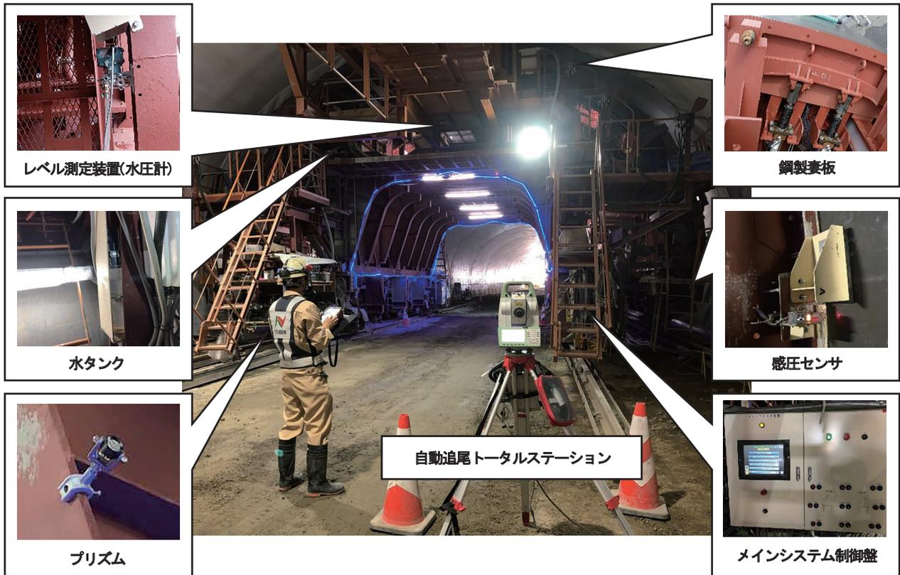
図-4 セントル自動セットシステム概要
