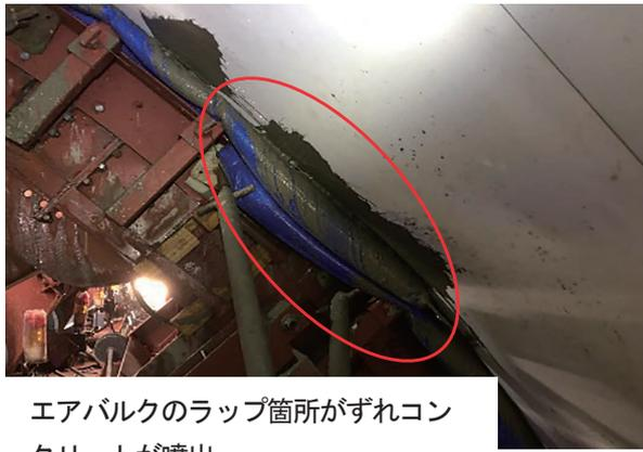
エアバルクのラップ箇所がずれコンクリートが噴出
