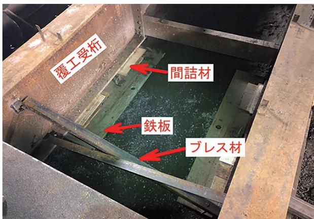
写真-4 覆工受桁支持状況
