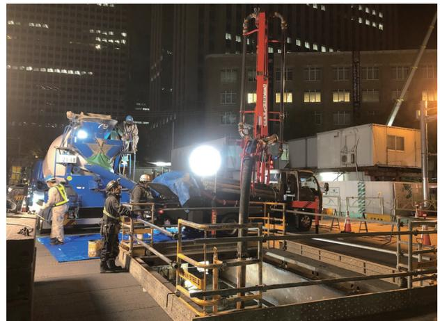
写真-5 流動化処理土打設状況
