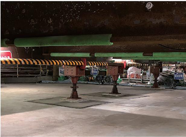
写真一2 頂部受替柱設置状況
