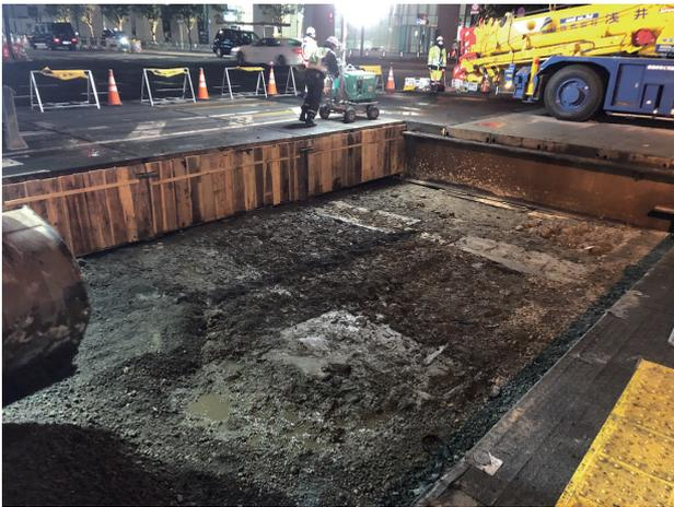
写真一七 路面覆工撤去完了
