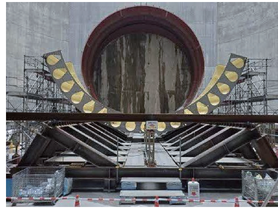
写真ー1 シールド組立中の状況 3)
