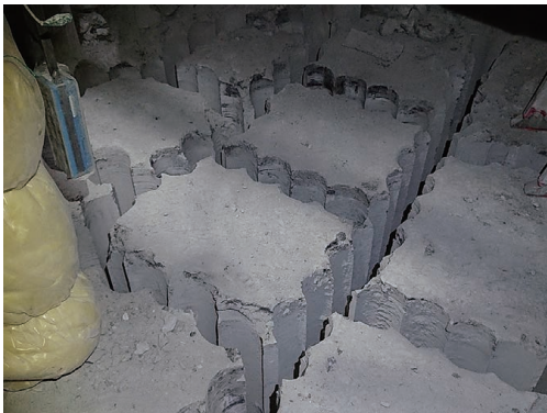
写真-6 コア削孔完了
