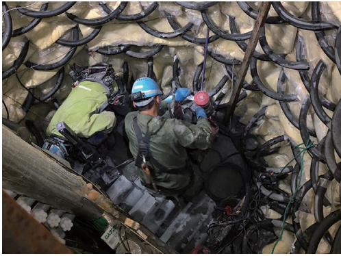
写真-4 コア削孔状況
