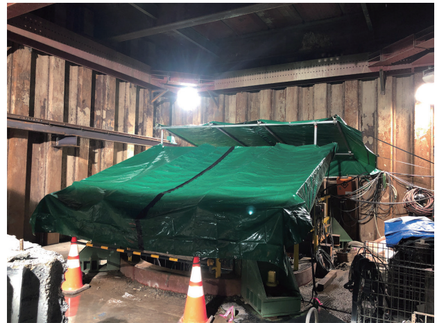
写真-15 雨水流入防止の仮設屋根
