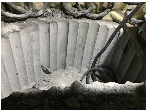
写真-7 コンクリート撤去完了
