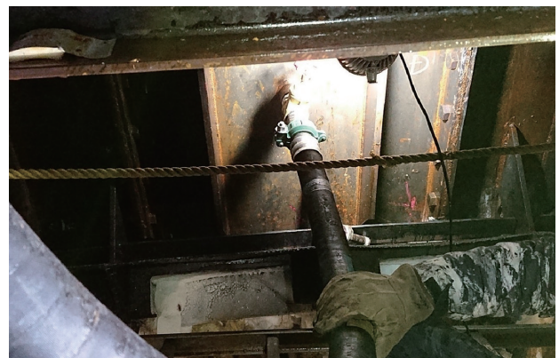
写真-12 セメントミルク注入状況
