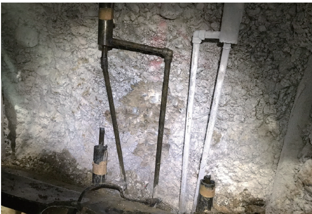
写真-10 バイパスライン設置完了
