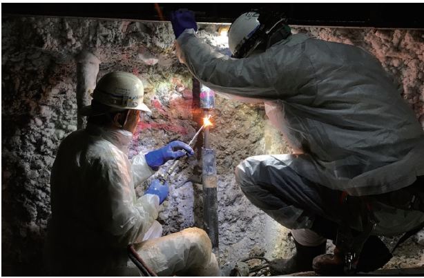
写真-9 バイパスライン設置状況
