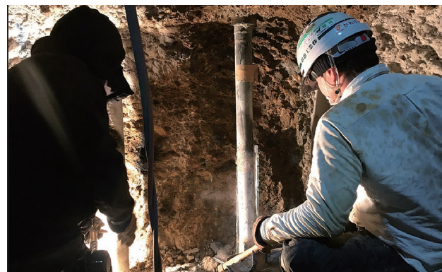
写真-8 凍土掘削状況
