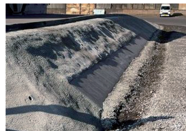
写真一9 法面保護（脚部）
