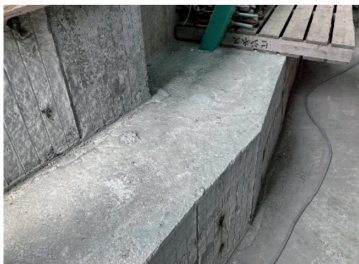
脱型後の状態
