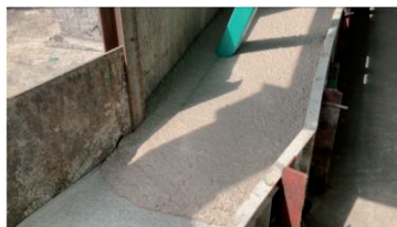
打込み中の流動状況（流動距離 3m）
