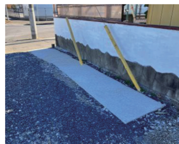
写真一七 土間コンクリート
