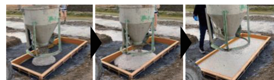
写真-4 コンクリートホッパーからの打込み
